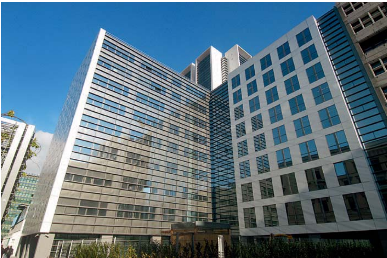
Abbildung 2: Druckbelüftungsanlage im Finanzministerium
