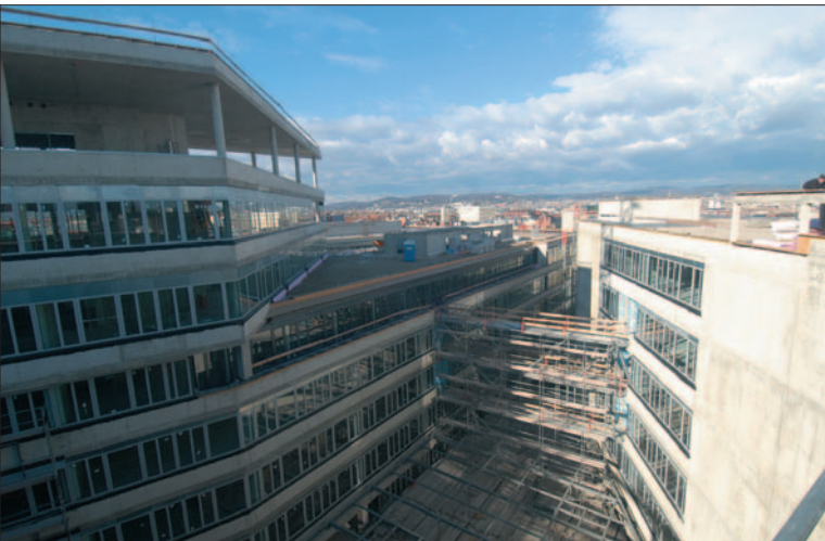
Die vierte Ausbaustufe des Bürocenters Europlaza in Wien 12 ist gerade in Bau
