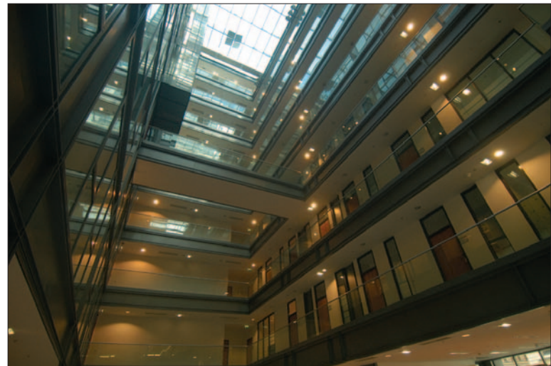
In der neuen Heimat des Finanzministeriums ist ein Druckbelüftungssystem zur Brandentrauchung realisiert worden
