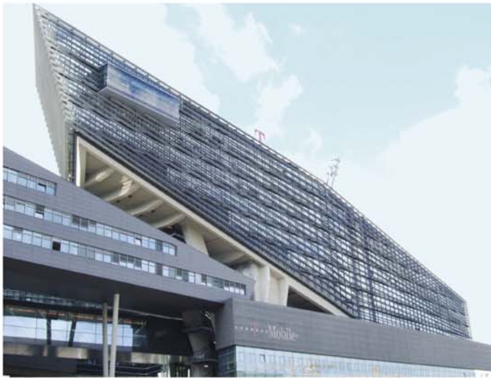
Das T-Mobile Center in Wien ist nur eines von vielen Projektbeispielen, wo G & P Air Systems ihr Know-how bei Druckbelüftungsanlagen einbrachte und natürlich die entsprechenden Produkte lieferte.
