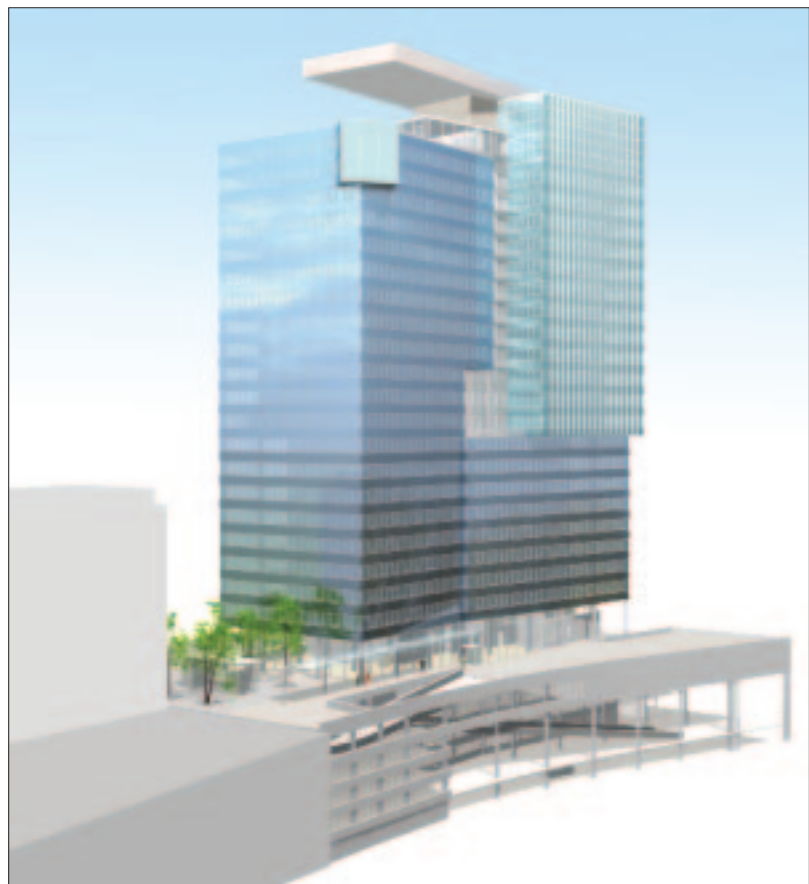
Der Saturn Tower verbindet Architektur und Gebäudetechnik auf höchstem Niveau
