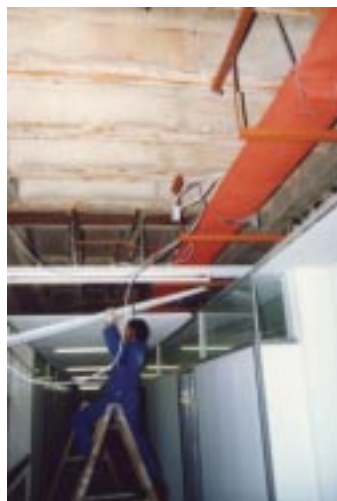
Schnell und einfach kann mit dem Hapuflam-Brandschutzgewebe auch nachträglich für genug Sicherheit gesorgt werden
